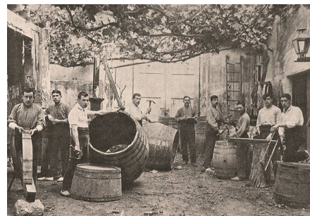
Figura 7. Construcció de bótes.
